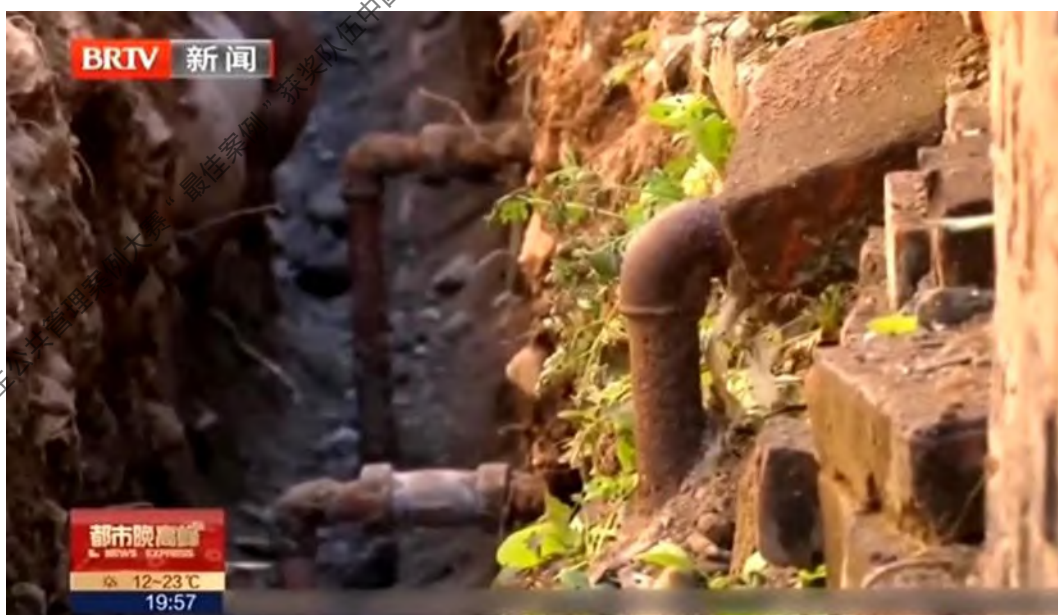
图 8 年久老化的水管
