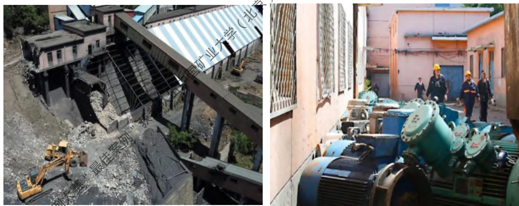
图6 大台煤矿设备拆除过程
